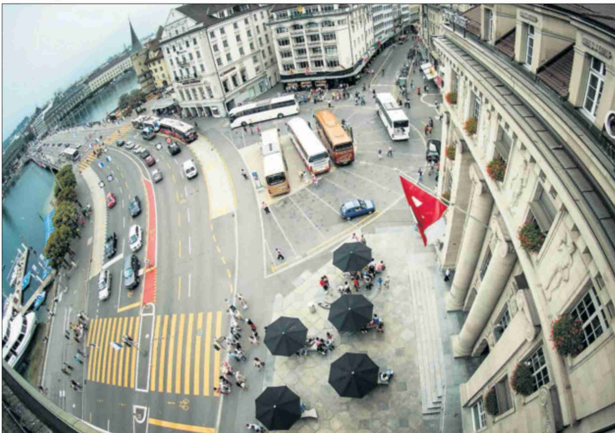
Vom Grendel bis in die Mitte des Schwanenplatzes führen die Werkleitungen, die saniert werden müssen.
